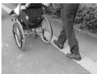
視覚障がい者誘導用ブロックがなかったり、老朽化している
