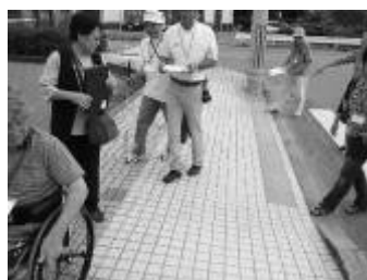
幅員が狭く、勾配がきつい箇所がある
