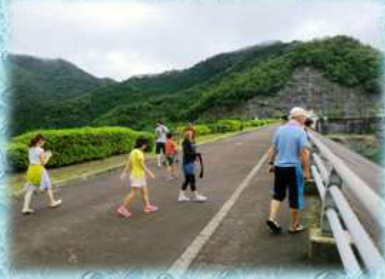
【ダムの堤体での学習】
