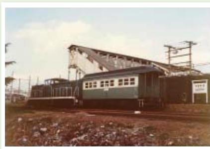
▲古いレールを使った土山駅の跨線橋
