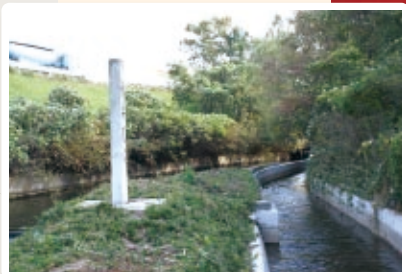
◀「五ヶ井」から分水した「新井」(右側水路)の起点付近
