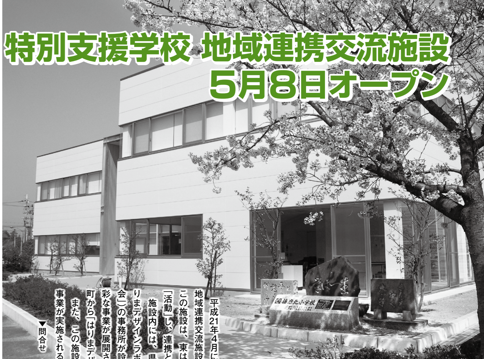
▲施設外観。敷地内には旧播磨北小学校の記念碑も設置されています
