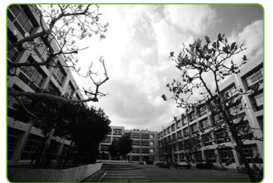
▲外壁塗装が終わったピカピカの校舎
