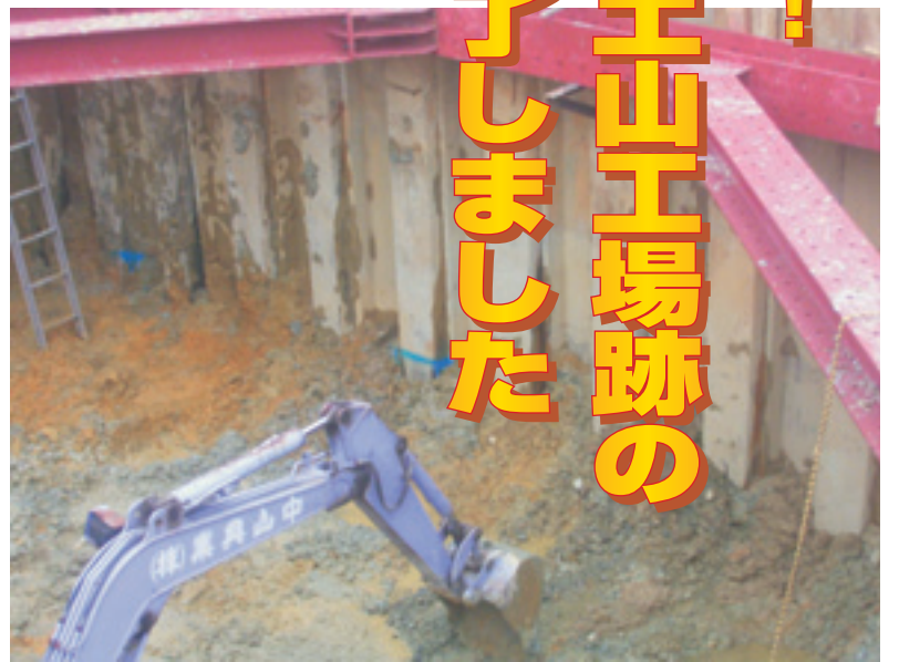
▲汚染土壌を掘削
