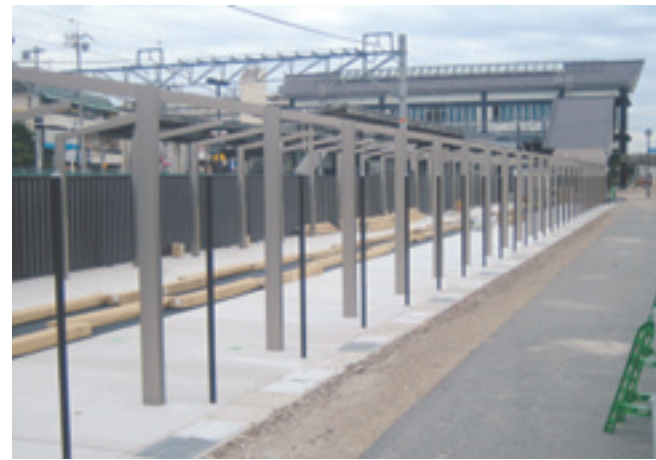
▼整備中の土山駅西自転車駐車場
