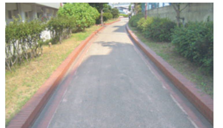
▲完成から20年近く経過した「であいのみち」
