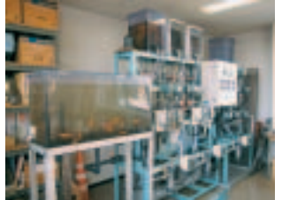
水質監視装置 原水に危険な物質が含まれていないかを常時調べています。
