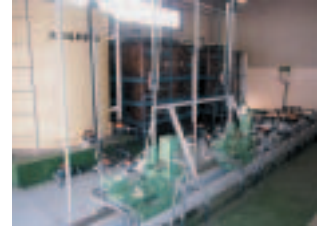
③薬品注入設備 原水の濁りや汚れを取り除く薬品や殺菌のために塩素を自動的に注入する設備です。
