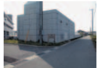
⑦配水池 水使用量の変化に関わらず、常に一定の圧力で水を届けるためにきれいな飲料水を貯めておく設備です。災害時には大きな水がめとして12時間分の飲料水を確保する役目も担っています。
