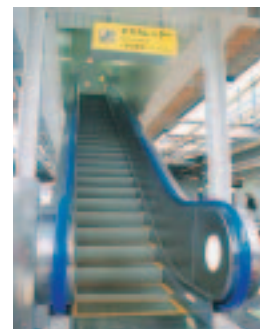
▶ホームから見たエスカレーター
