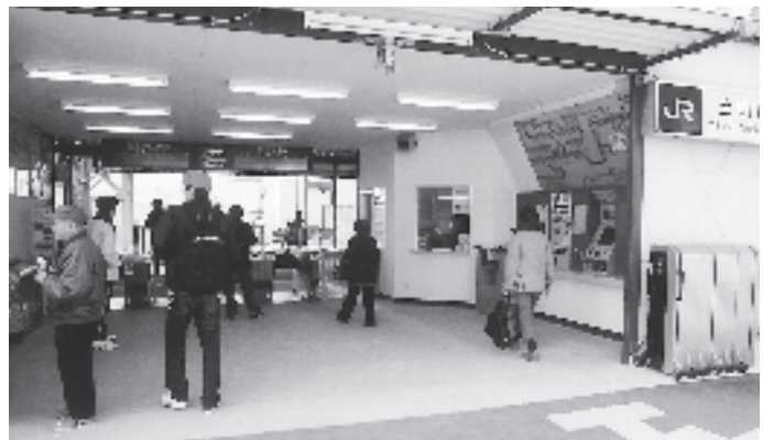
JR土山駅の仮駅舎の利用が始まり、新駅舎の工事もいよいよ本格化します。
