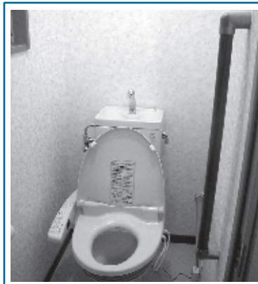
洋式便器、 手すり設置
