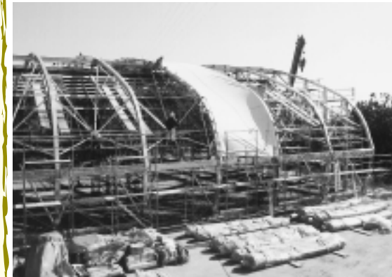
急ピッチで進む工事
