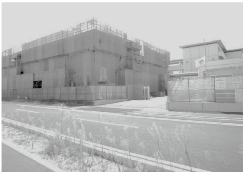
▲改修工事中の南中体育館
