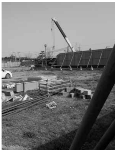
▲土壌改良工事の進捗 JR土山駅南町有地
