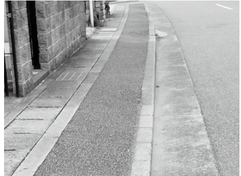
▲勾配が連続する歩道
