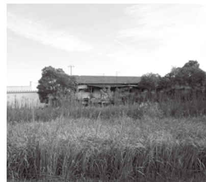
解体が待たれる所有者不明の建物
