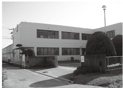
▲第3浄水場（北古田1丁目）
