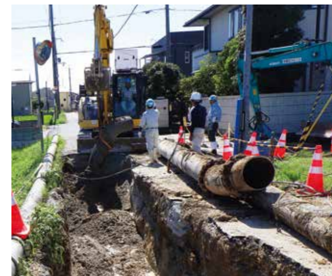
▲水道管の布設替え工事（大中地区）
