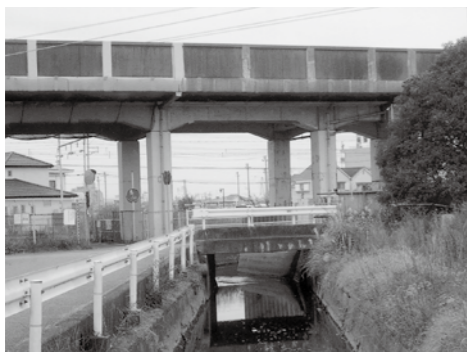
▲拡幅工事が待たれる新幹線下の水田川
