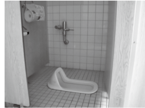
▲蓮池小学校の和式トイレ
