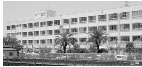
▲昭和51年竣工の西小学校
