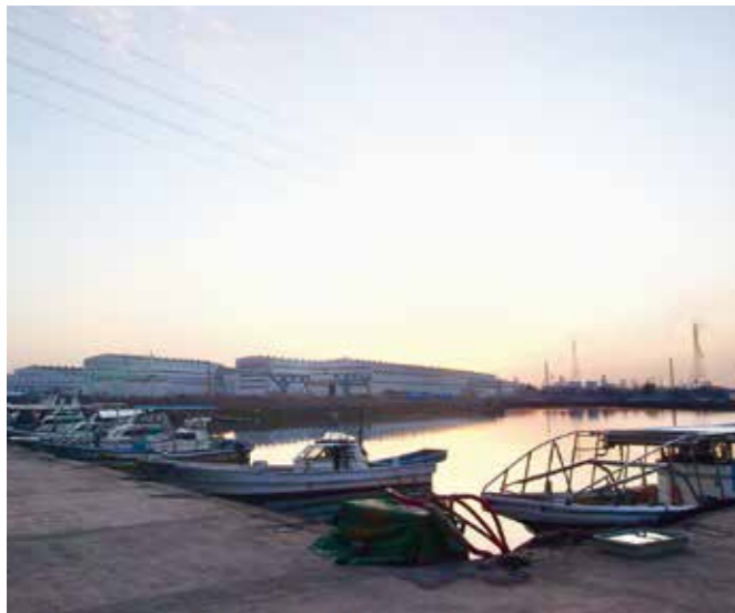
▲定期点検により安全な漁港施設に（古宮漁港）
