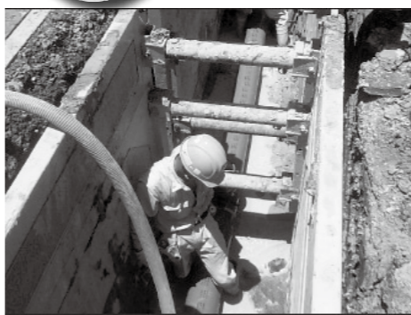
▲下水道工事の現場
