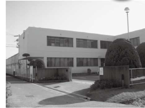
▲安全な水を届けるために毎日働く浄水場
