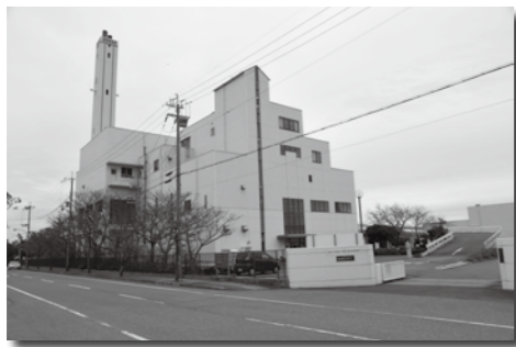
▲塵芥処理センター
