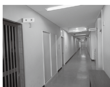
▲美しく改修される研修棟
