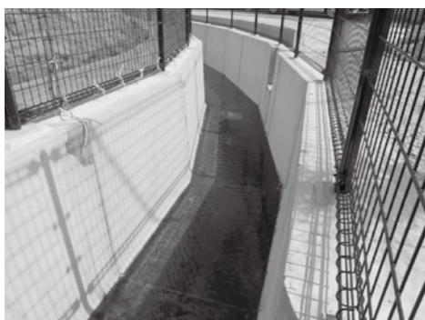
▲改修された排水路（東野添3丁目）
