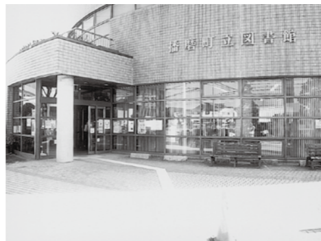
▲外壁の改修が予定される図書館
