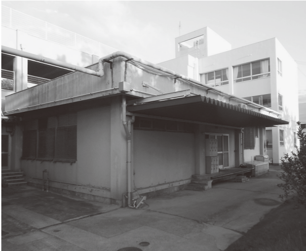
▲改修が必要な給食棟
