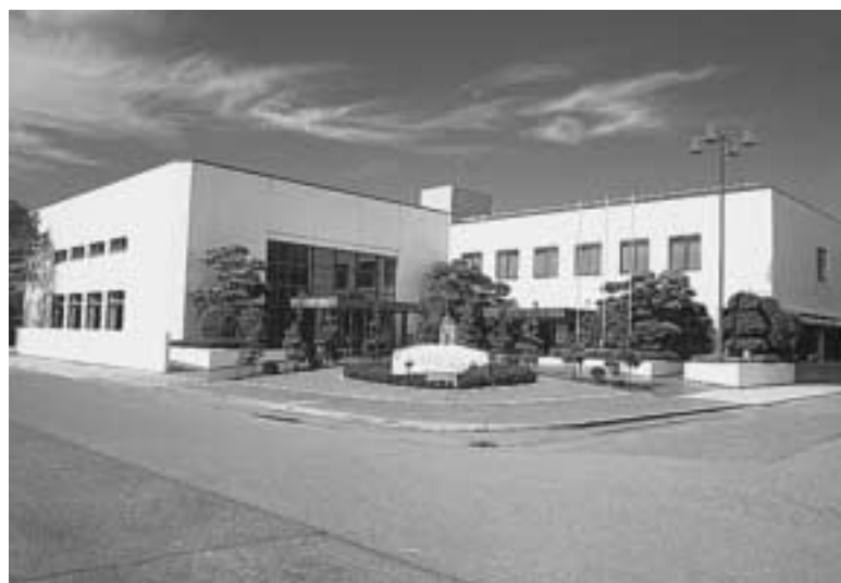
▲改修により使い易くなる中央公民館
