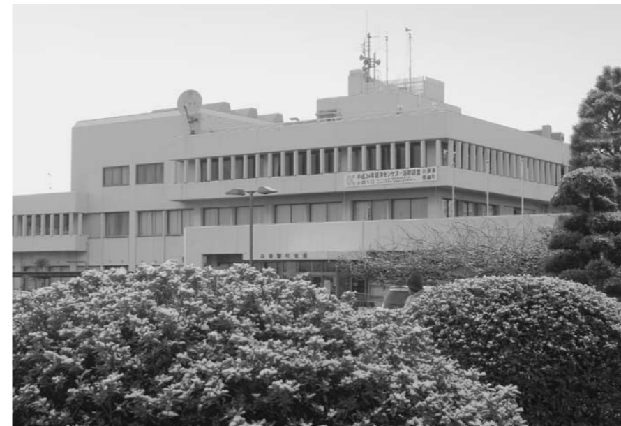
▲災害対策本部が設置される庁舎
