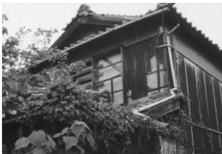
▲長年放置され雑草が生い茂る危険な建物
