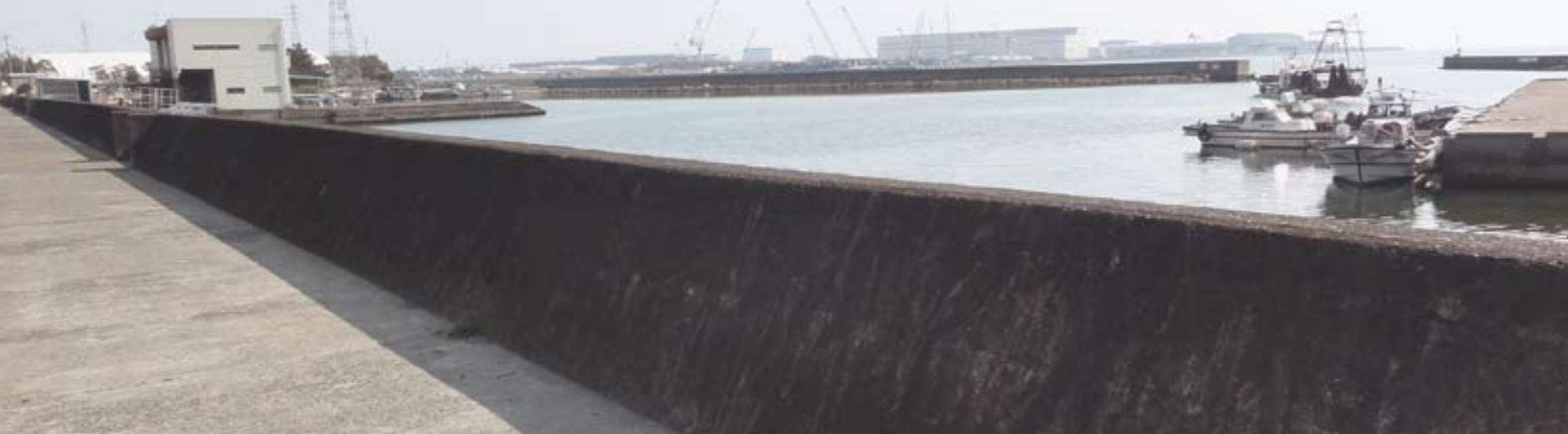
▲古宮漁港に設けられた防波堤
