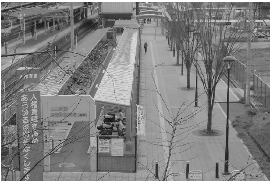
▲JR土山駅南自転車駐車場
