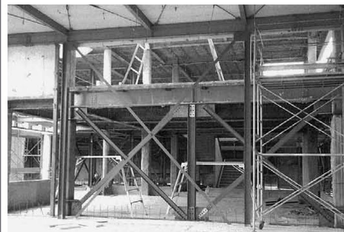
▲耐震補強中の播磨幼稚園
