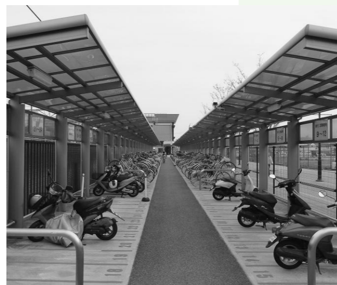
▲雨対策が望まれる土山駅西駐輪場
