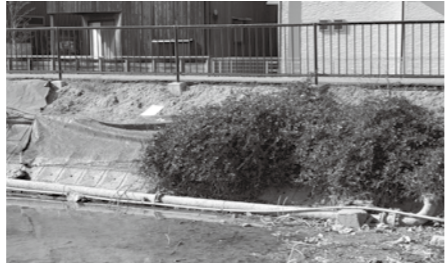
▲大池堤体の土表面の状況
