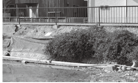
▲大池堤体の土表面の状況
