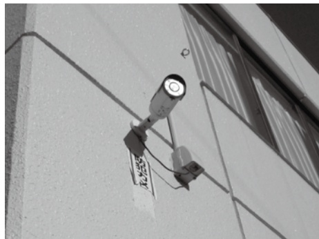
▲現在設置の防犯カメラ（自治会設置）
