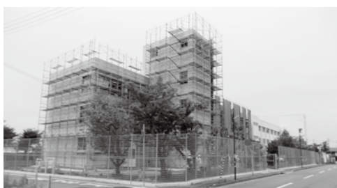
▲快適な校舎へ向けて工事が進む
