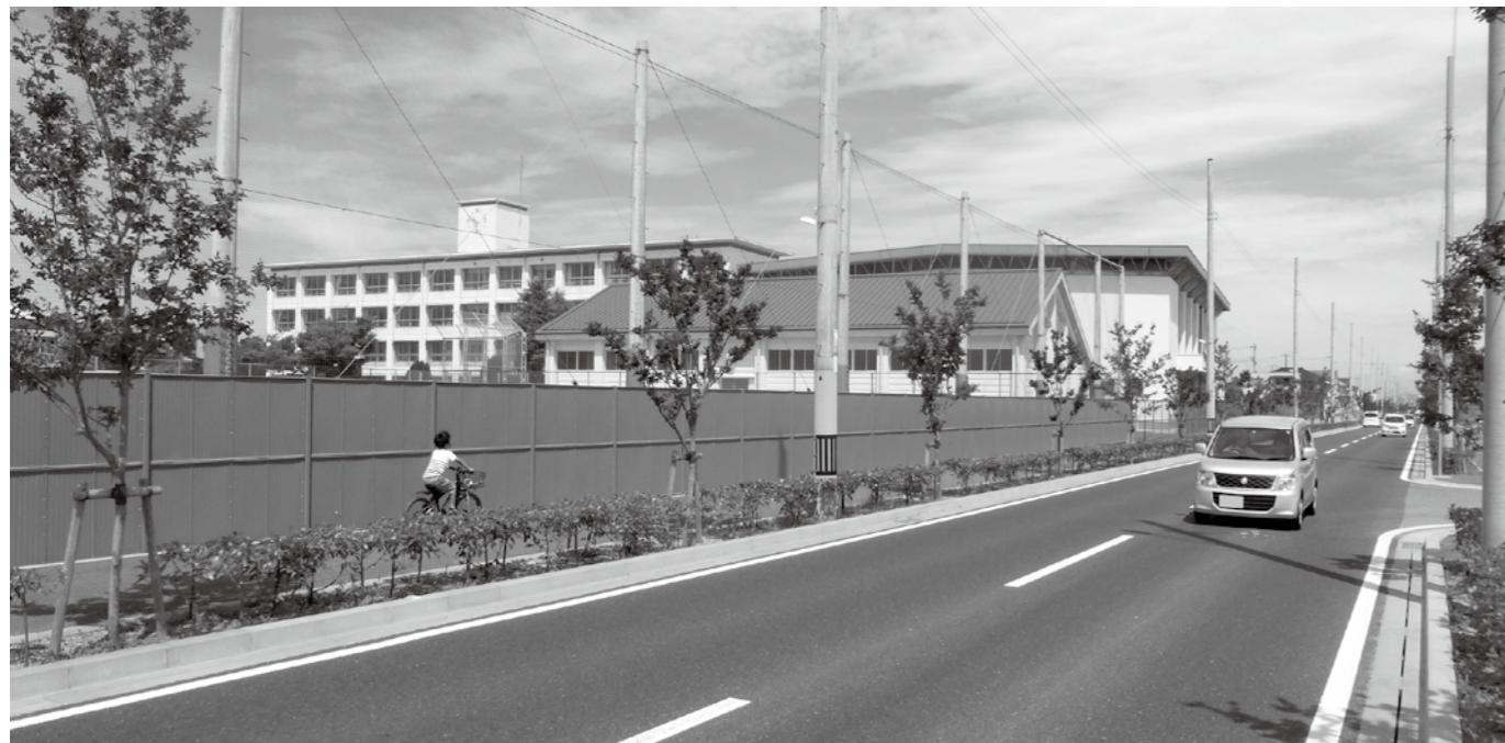
▲町道浜幹線からのぞむ南中
