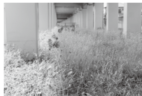
▲新幹線高架下の現状
