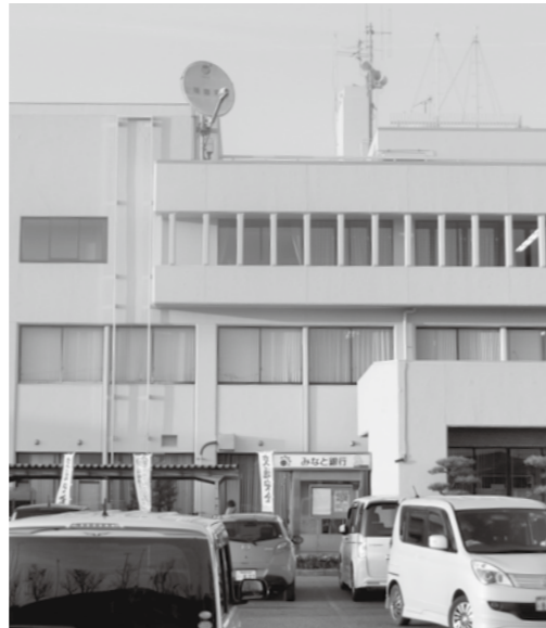
▲兵庫県衛星通信ネットワークを受信するアンテナ(庁舎屋上)
