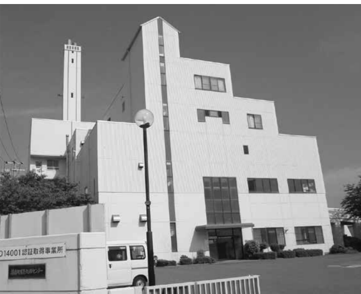
▲塵芥処理センター
