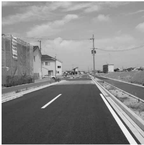
▲完成が待ち望まれる浜幹線道路
