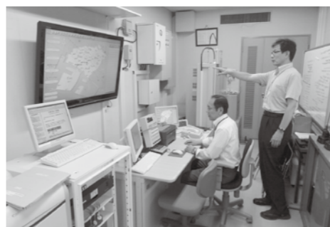
▲庁舎内防災無線室
