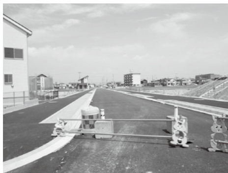
▲工事中の浜幹線事業
