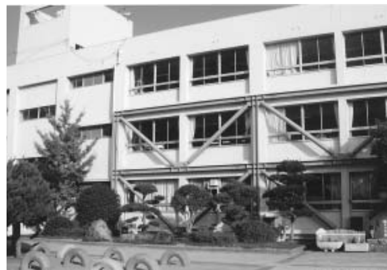
▲耐震補強工事が完了した蓮池小学校
