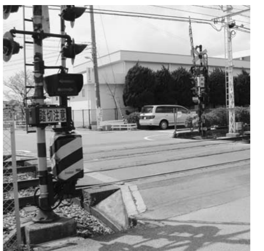
▲拡幅工事を計画している山陽電車大中踏切
