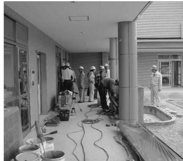
▲改築工事の完了前に視察が行われた播磨西幼稚園
