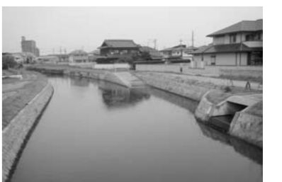
▲整備が進む水田川
