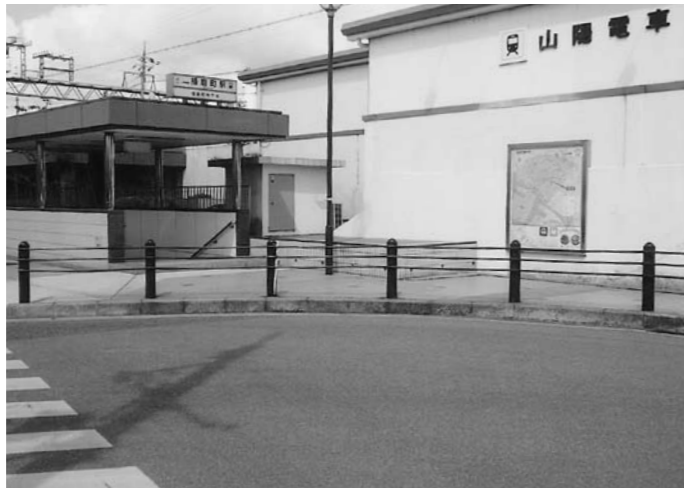
▲平成24年度にエレベーター工事予定
