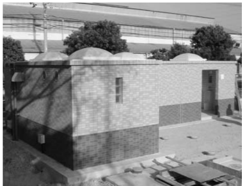
▲工事が進む新島中央公園内トイレ
